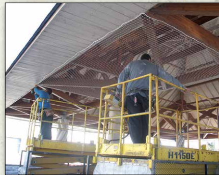
Pose d'un filet sous la halle pour incommoder les pigeons indésirables.
