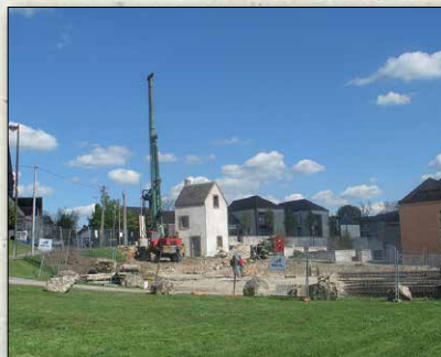
La ferme Pautre, en cours de réhabilitation, va accueillir trois services de la ville : le culturel, l'éducation/enfance et la communication.
