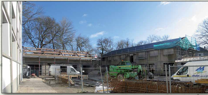
Les travaux de la future École d'art vont bon train. Les Tannereries finissent de se métamorphoser.
