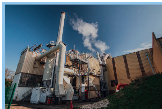
Une Unité de Valorisation Énergétique
