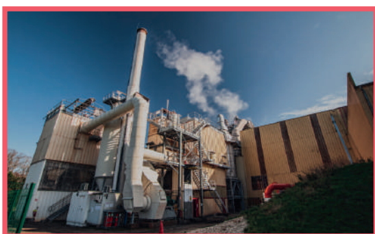
Unité de Valorisation Énergétique à Amilly
