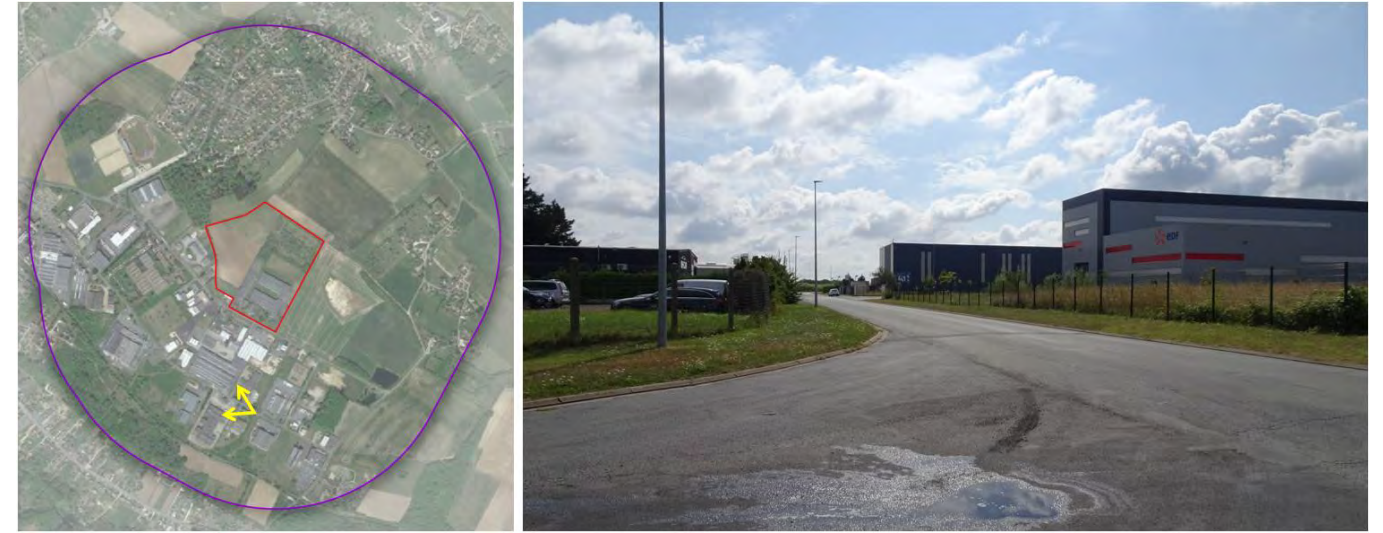
Figure 128 : Photographie de la traversée de la zone industrielle d'Amilly (Crédit photo : NCA Environnement)
