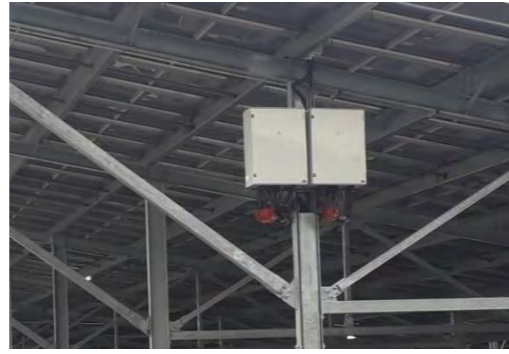
Figure 15 Exemple d'installation d'onduleur string
