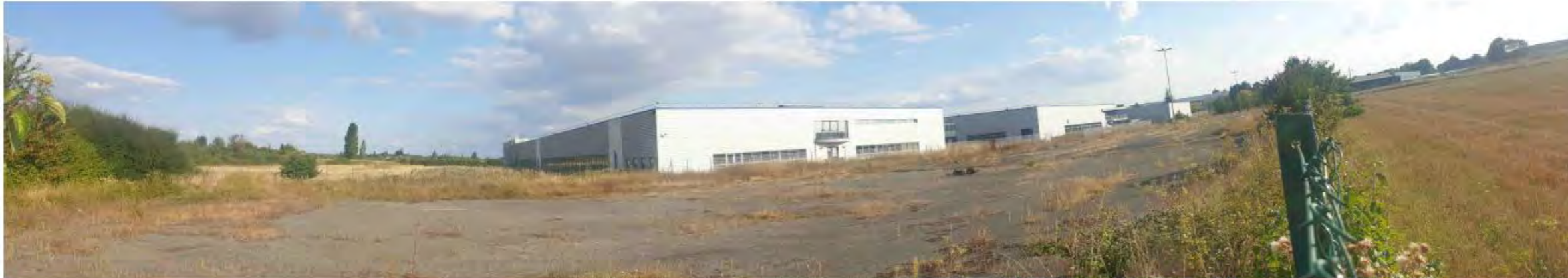
6-Vue Nord-Ouest - Zone stationnement du personnel
