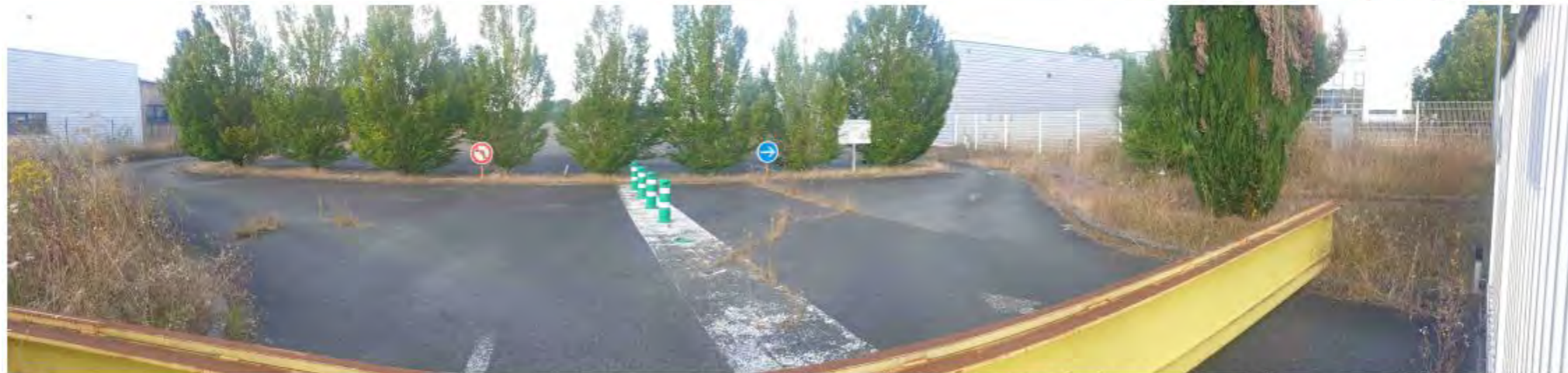
8-Vue Sud-Ouest - Entrée/Sortie du stationnement du personnel
