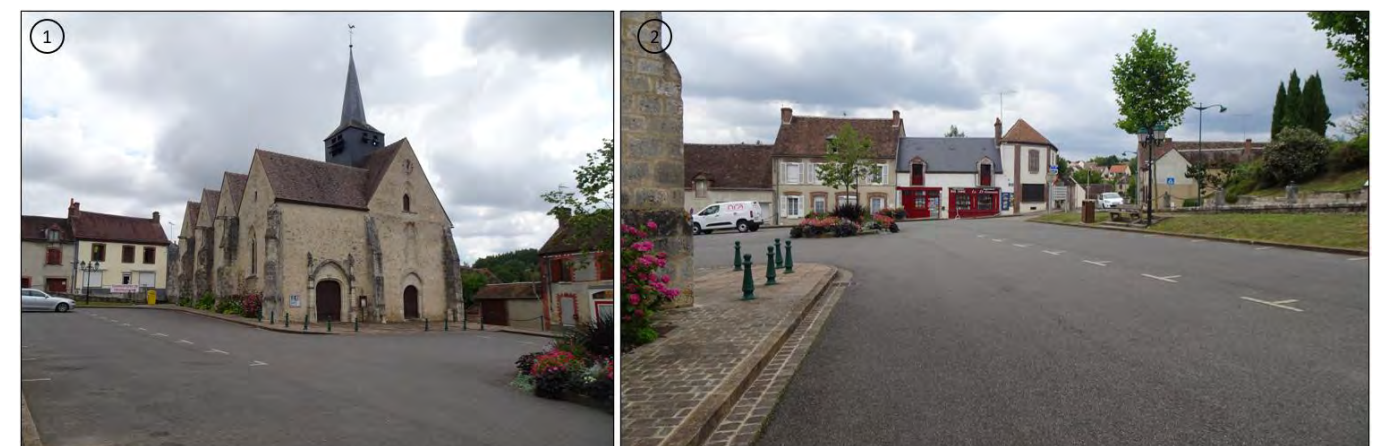
Figure 120 : Prise de vue 1 - Photographie de l’Eglise de Saint-Germain-des-Prés / Prise de vue 2 – Photographie du paysage visible depuis le monument en direction du site d’étude
