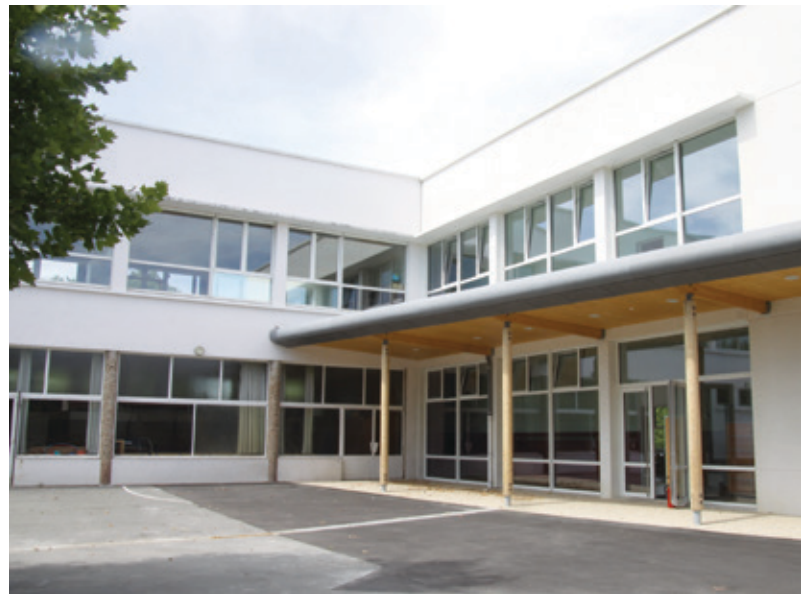
À l'extérieur comme à l'intérieur, la liaison entre le bâtiment principal et l'extension (partie droite de la photo) se remarque à peine.
