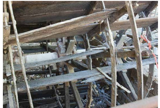
L'ancienne roue, hors d'usage, a été déposée.
