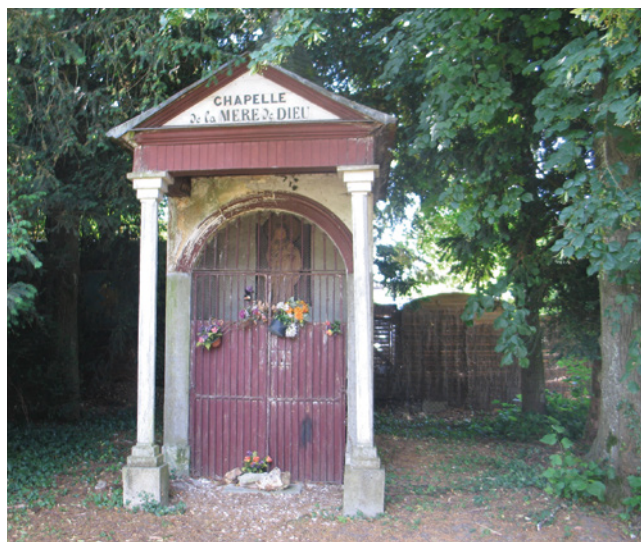
Chapelle de la Mère-Dieu, accessible en descendant des escaliers situés rue de la Mairie.
